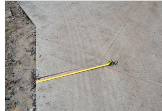
Aansluitingen van wegen Detail: ligging van de voegen
