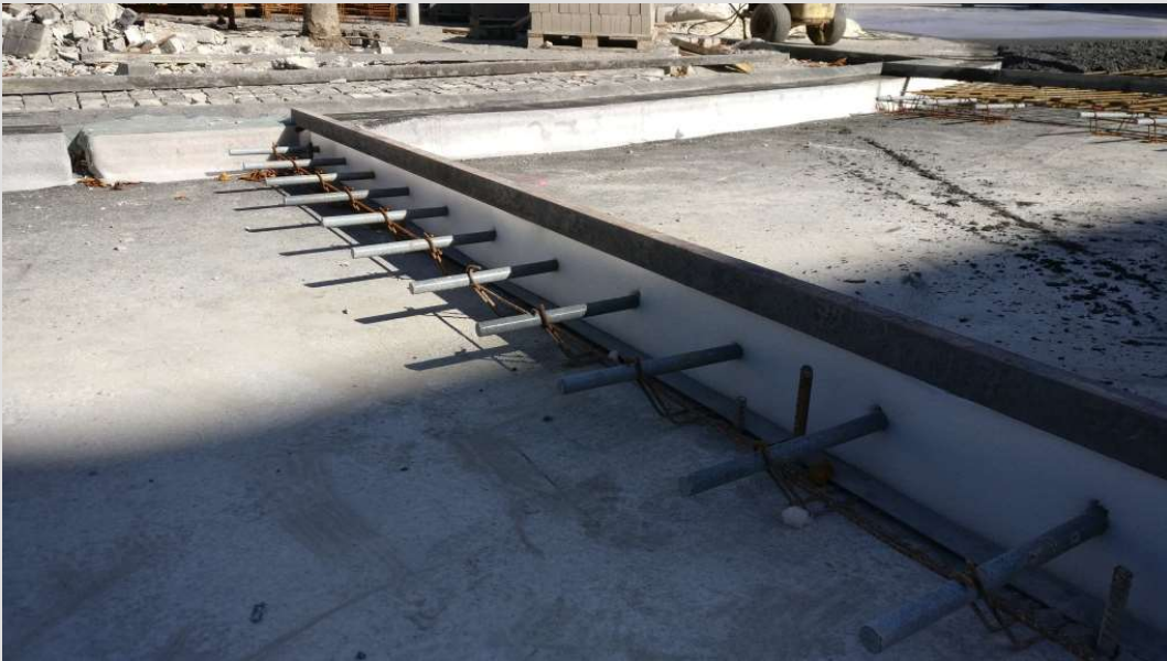
Een vakkundig uitgevoerde gedevelde uitzetvoeg, geplaatst op stevige develstoelen, met een samendrukbare voegplaat in hoge densiteit polyethyleenschuim, over de volledige hoogte en breedte van de rijweg. Bovenaan bevindt zich een metalen lat, die na het betonneren wordt verwijderd, zodat bovenaan geen 'betonbrug' kan ontstaan en spanningsconcentraties vermeden worden.
