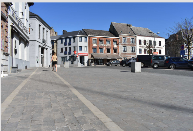
Combinatie van het uitgewassen rijwegbeton en de stoepen in betonstraatstenen.
