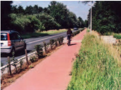
Pistes cyclables en béton coulé en place
