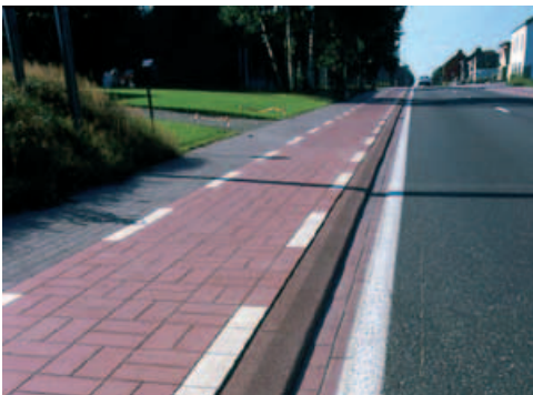
Pistes cyclables en béton coulé en place
