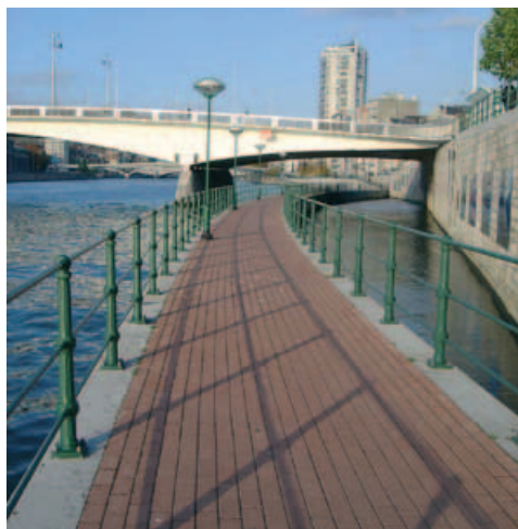
Piste cyclable en pavés de béton
