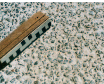
Surface traitée par lavage ou dénudage du béton. Les granulats sont mis en évidence tout en assurant un très bon confort de roulement.
