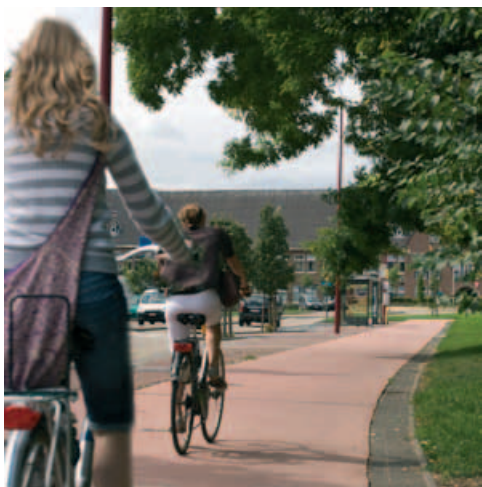
Piste cyclable en béton coulé en place
