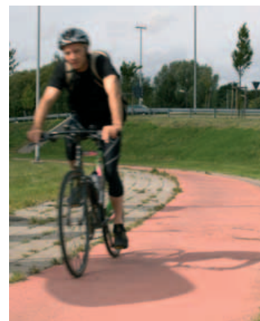
Piste cyclable en béton coulé en place
