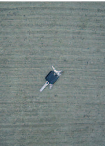
Surface traitée par simple brossage, la technique la plus utilisée.
