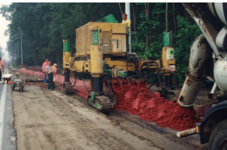
Mise en œuvre au 'slipform' (coffrages glissants)
