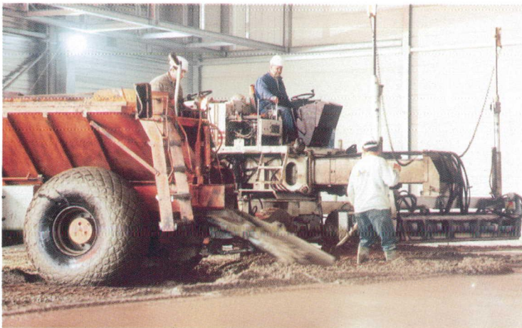
Storten van beton met behulp van een dumper
