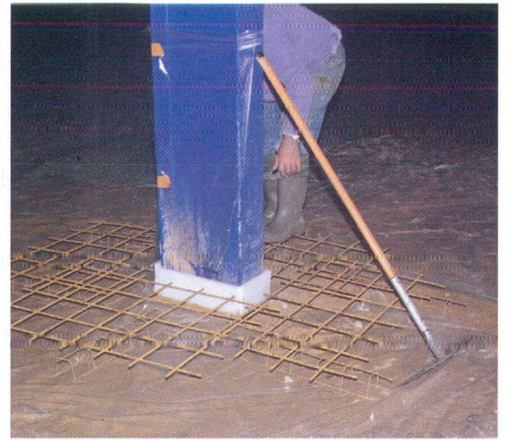
Scheidingsvoeg rond kolons: samendrukbare strook en wapeningsnet
