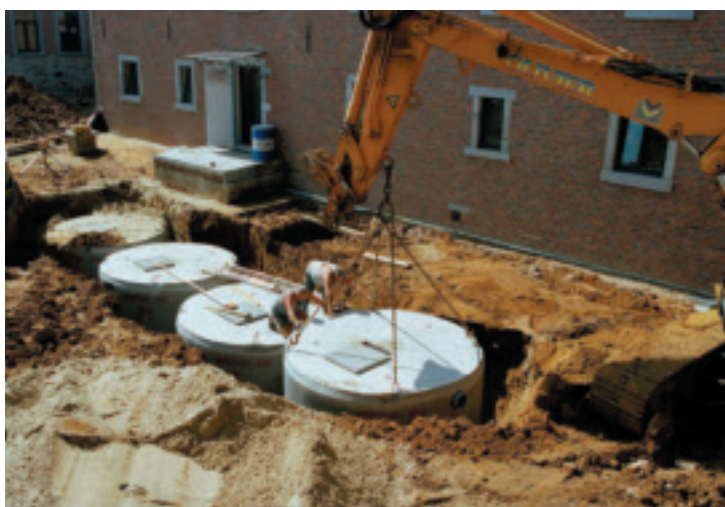
Plaatsing van 4 tanks in serie: - vetafscheider - septische put - bioreactor - nabezinker [foto's André Nullens]
