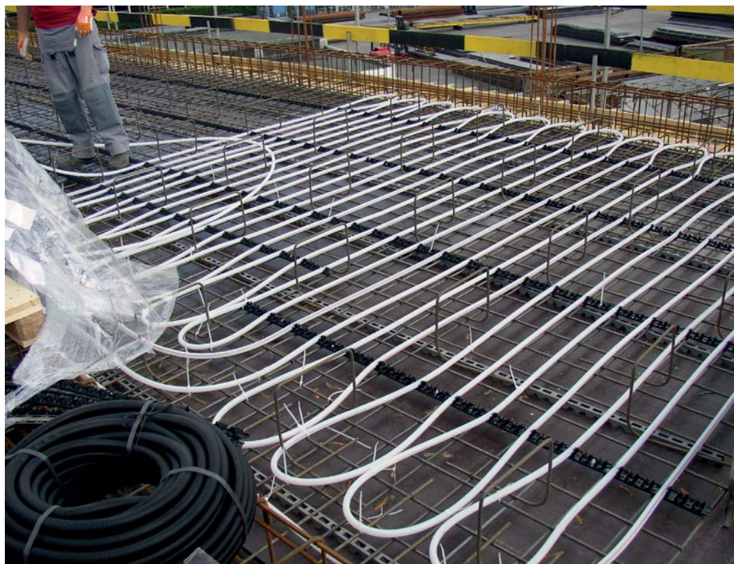
TABS, activation thermique intégrée de dalles de béton
