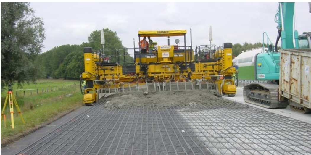
Rénovation de l'autoroute A10/E40 en béton armé continu, Groot-Bijgaarden-Ternat 2003
