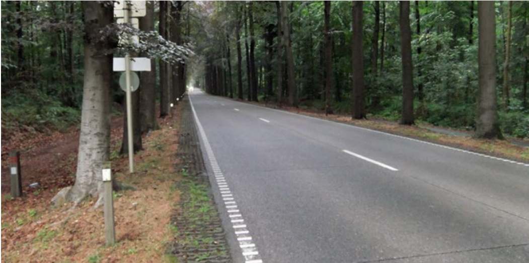
La Drève de Lorraine à Uccle, 20 ans en service après un recouvrement en dalles de béton en 2003.
