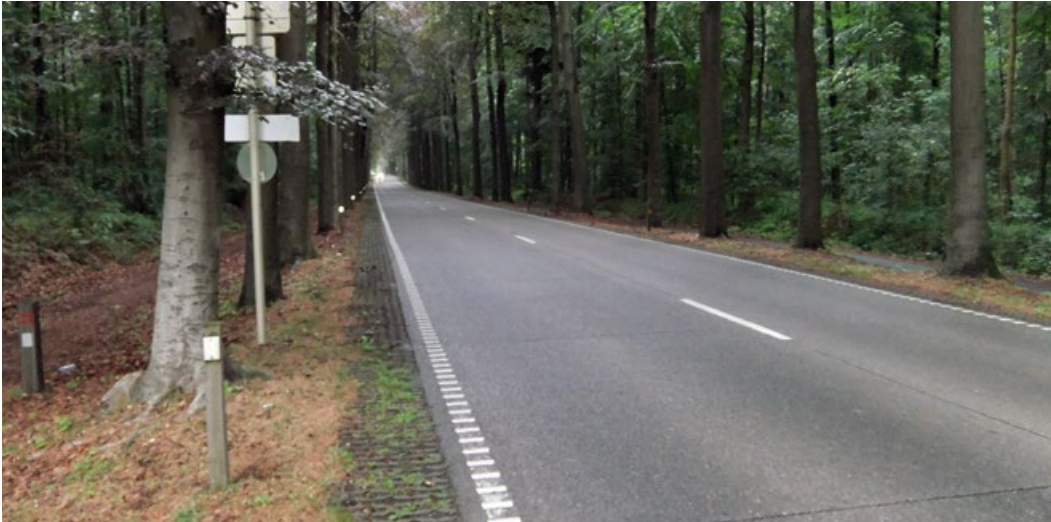
De Lorrainedreef te Ukkel, 20 jaar in dienst na de overlagging in platenbeton in 2003.
