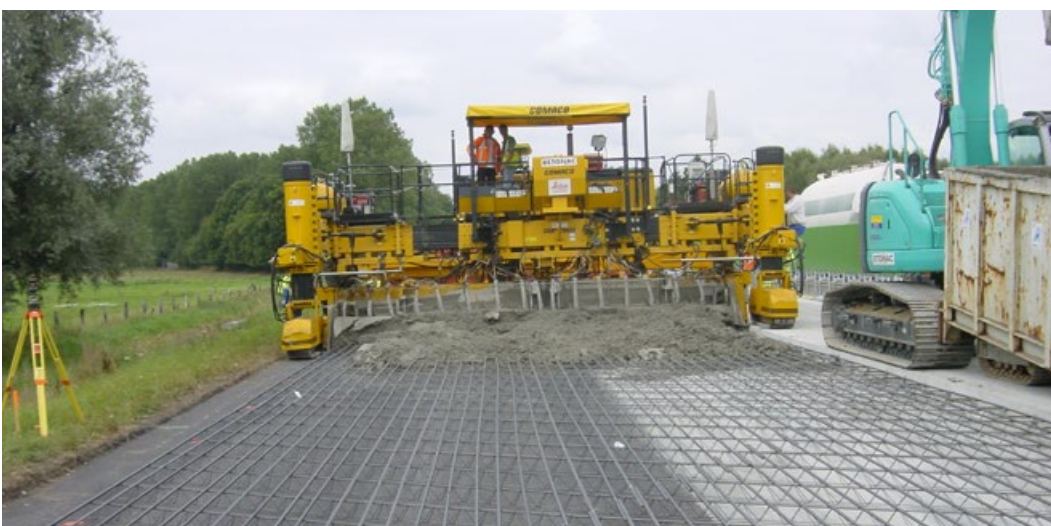
Renovatie van de autosnelweg A10/E40 in doorgaand gewapend beton, Groot-Bijgaarden-Ternat, 2003
